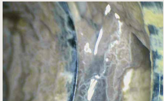
Abb. 1: Biofilm im Leitungsrohr, Copyright© Kerstin Protz, Hamburg
